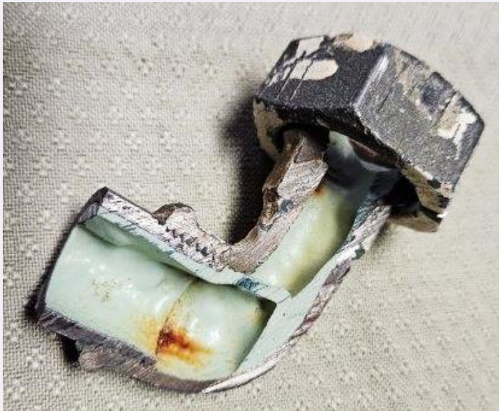
Abbildung 4: Beispiel Vollfüllung einer Rohrleitung mit Beschichtungsmaterial an Winkel-Formteil
