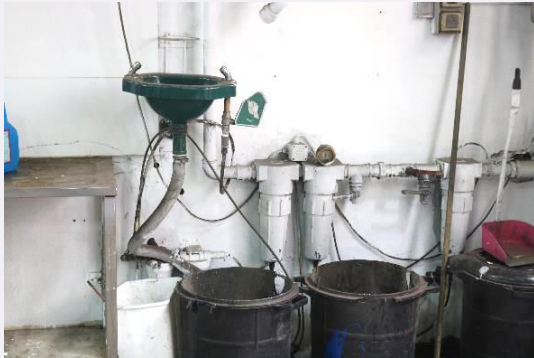
Abbildung 11: Notduschen müssen sauber und zugänglich sein und dürfen nicht durch Lagergut verstellt werden
