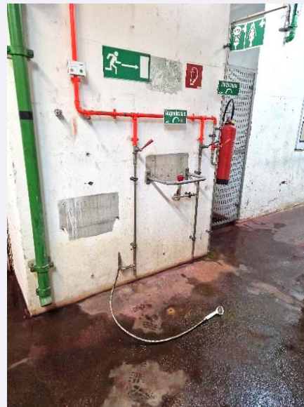
Abbildung 7: Sind flexible Schlauchleitungen mit Handbrausen zu lang bemessen, kann es zu erheblichen Verunreinigungen kommen; Quelle: DVQST e.V.
